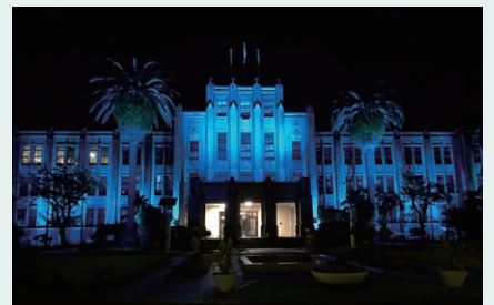
宮崎・宮崎県庁本館
